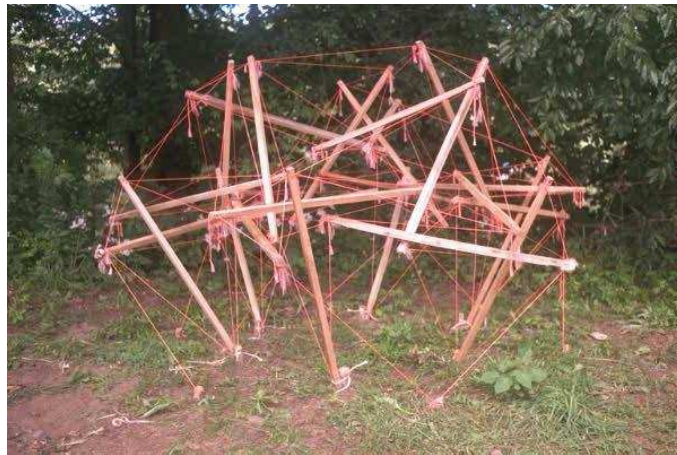
FIG. 2.1 – Dôme de tensegrité, réalisé par Robert Burkhardt. [14]
