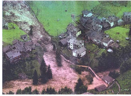
Figure 1.8. Zone de Confluence de torrents en une Région Alpine de la Valtellina (Exondation du 1987)
