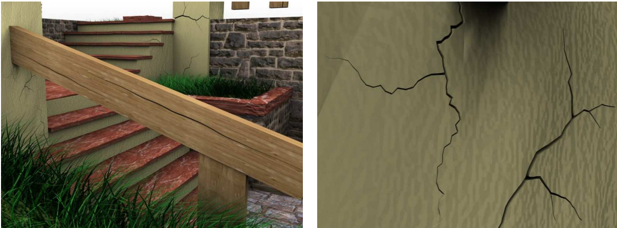
FIG. 5.17 – Main courante en bois fendue dégradant le mur qui la soutient.
