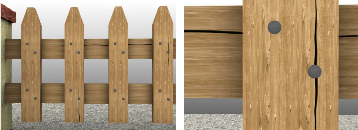
FIG. 5.18 – Barrière en bois abîmée par le temps.
